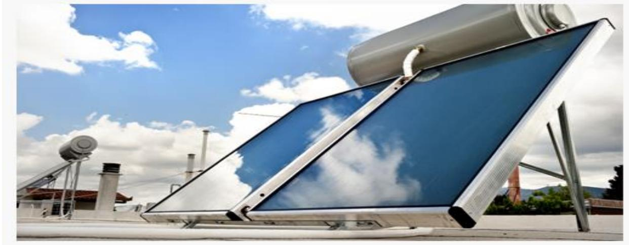
In un impianto solare termico l'energia viene trasferita dalla luce solare all'acqua attraverso un pannello posto sul tetto dell'abitazione, un circuito idraulico chiuso e un serbatoio di accumulo dell'acqua. Ci sono due tipi di impianti: a circolazione naturale e forzata.
